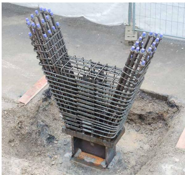
Hochfeste Top700 Stützenbewehrung mit BARTEC® TOP Schraubverbindungen
